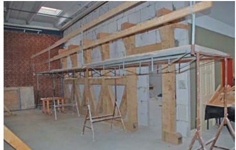
Rekonstruktion af bindingsværket på Møntergården i Odense. Ebbe Hædersdal foto 2010.
