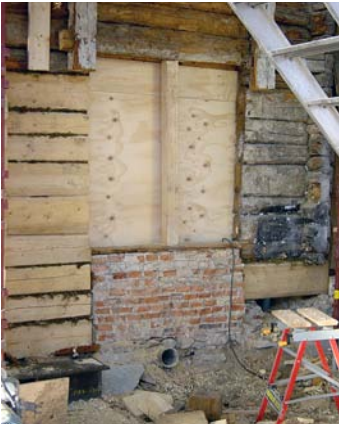
Frogner hovedgård. Et vindu som ble til dør som så ble gjenmurt – og så laget man badeværelse innenfor, med utløp gjennom grunnmuren. Lars Roede foto 2007.
