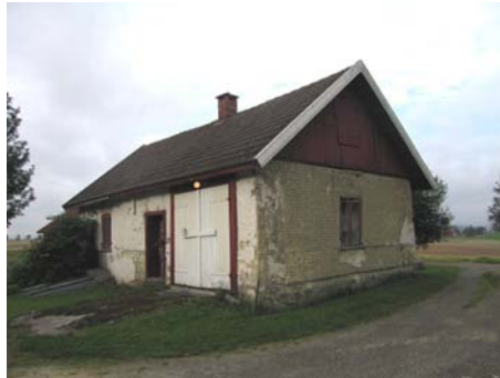
Bryggerhus fra ca. 1870 med vegger av rå murstein på Fladby store i Ullensaker kommune i Akershus
