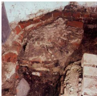
Tv. Professorboligen och Konsistoriehuset från söder. Emil Clausen. foto ca. 1900, Det kgl. biblioteket. Th. Kaminfundament i Professorboligens källare. Ebbe Hædersdal foto 1985.
